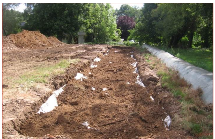
Mise en place du géotextille et de la terre végétale
