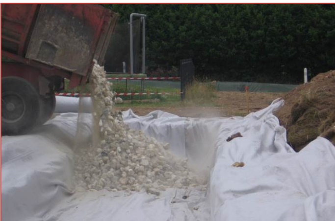
Mise en place de la grave
