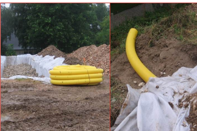
Installation de la canallisation de drainage
