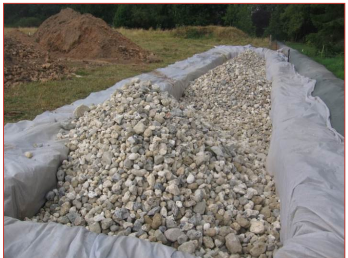
Mise en place du géotextille
