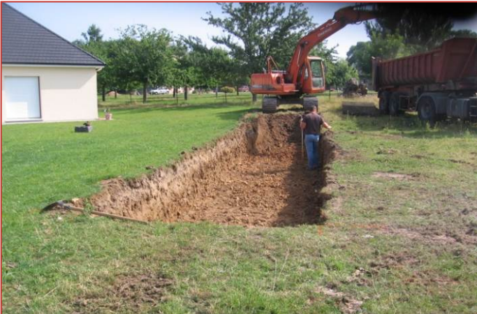
Terrassement du massif drainant
