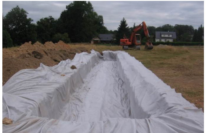
Mise en place du géotextille
