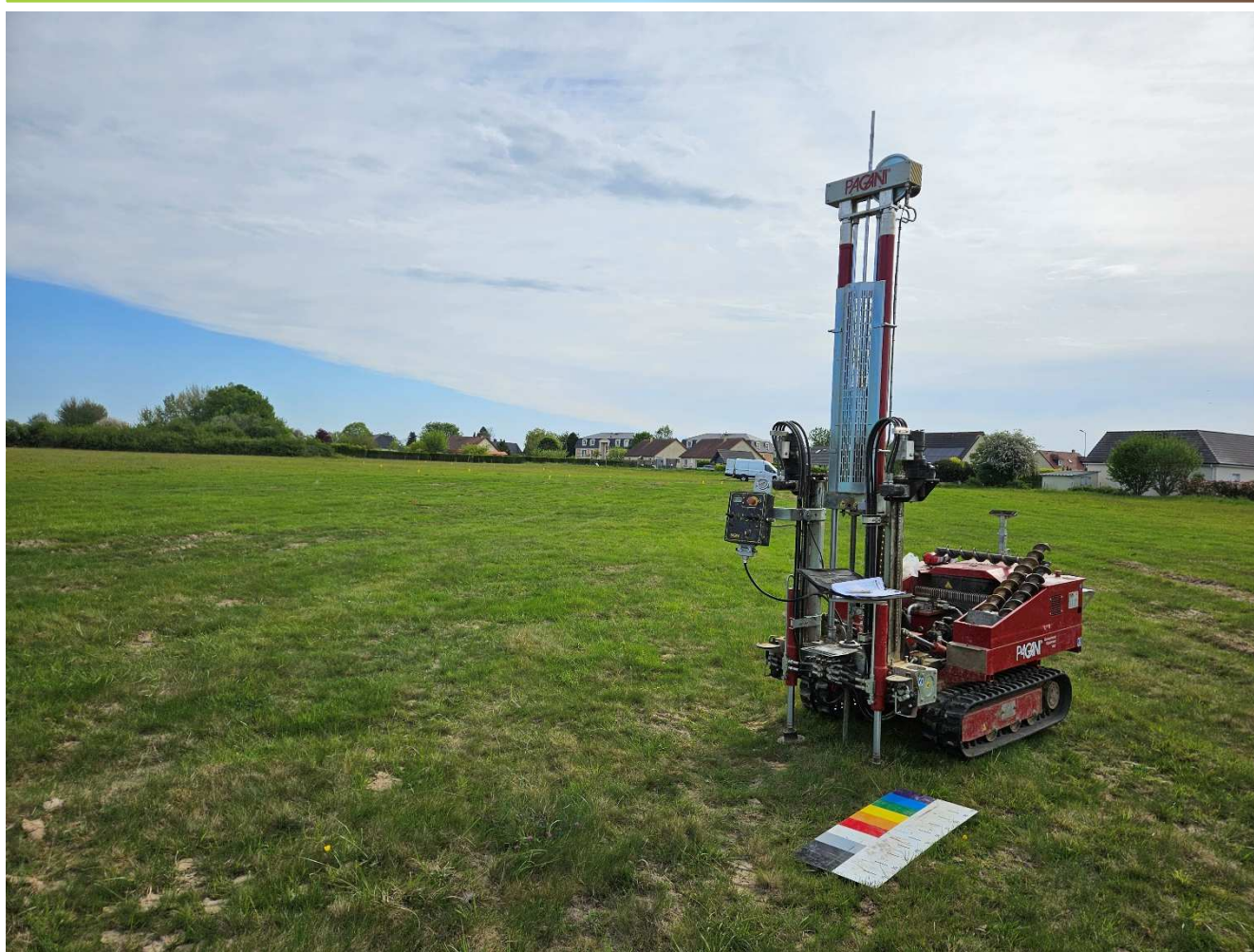
Photographie d'un sondage en cours sur le site
