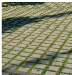
Pavés béton à joints enherbés
