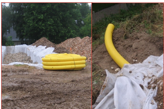
Installation de la canalisation de drainage
