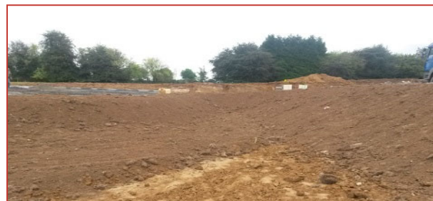
Recapage de la terre végétale
