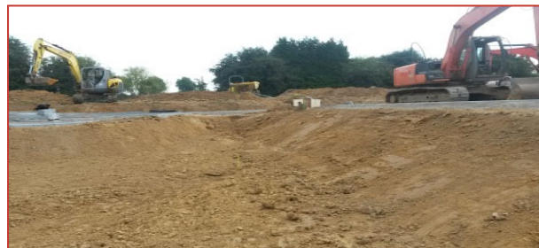
Réalisation des terrassements
