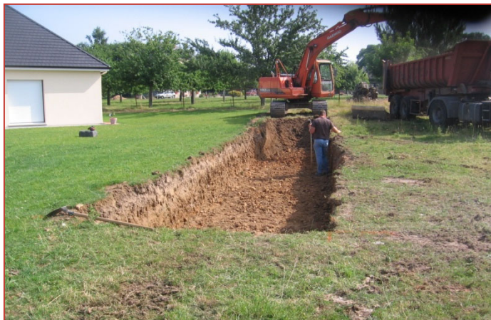
Terrassement du massif drainant
