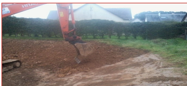
Décompactage et griffage
