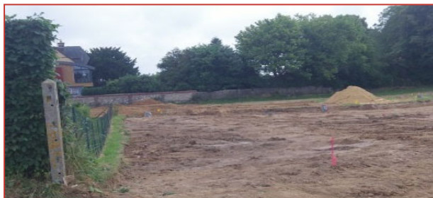
Décapage de la terre végétale
