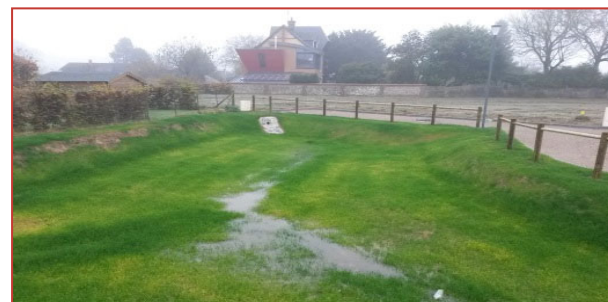
Première mise en eau de l'ouvrage
