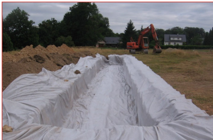
Mise en place du géotextile
