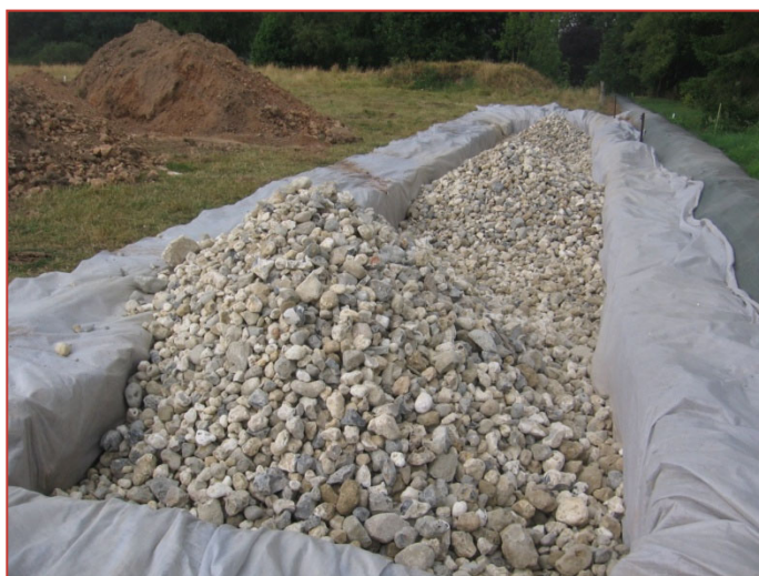
Mise en place du géotextile
