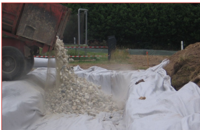
Mise en place de la grave
