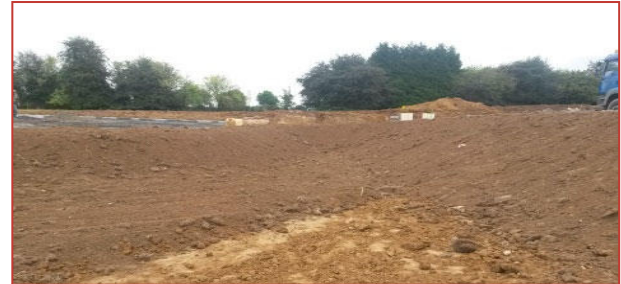
Recapage de la terre végétale
