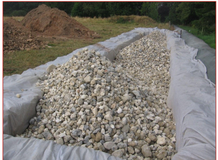
Mise en place du géotextile
