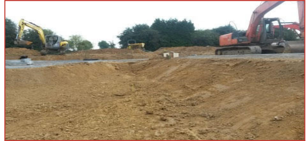
Réalisation des terrassements
