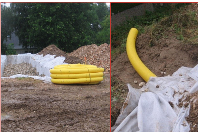
Installation de la canalisation de drainage
