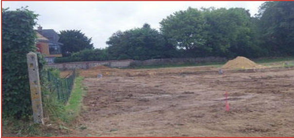
Décapage de la terre végétale
