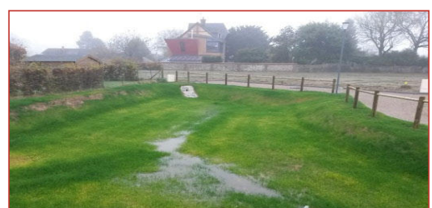
Première mise en eau de l'ouvrage
