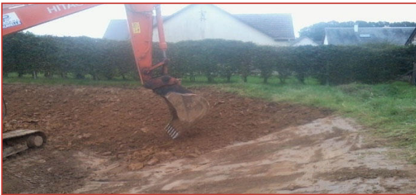
Décompactage et griffage
