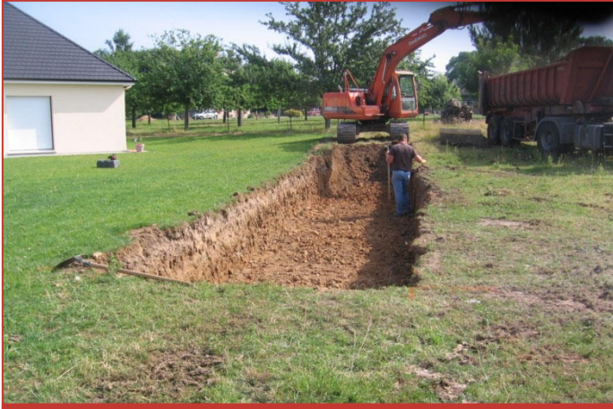
Terrassement du massif drainant
