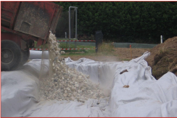
Mise en place de la grave
