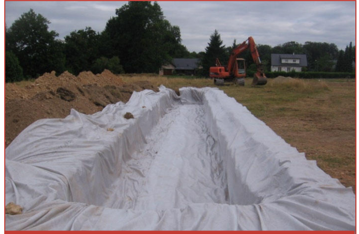
Mise en place du géotextile
