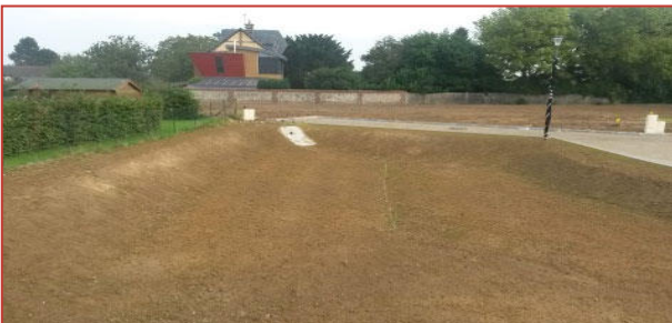
Finition des terrassements
