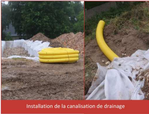
Mise en place du géotextile et de la terre végétale
