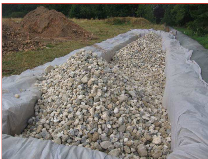
Mise en place du géotextille
