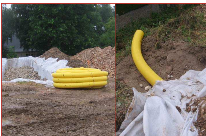
Installation de la canallisation de drainage
