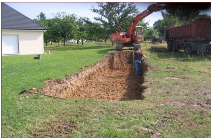
Terrassement du massif drainant
