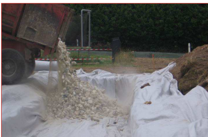
Mise en place de la grave
