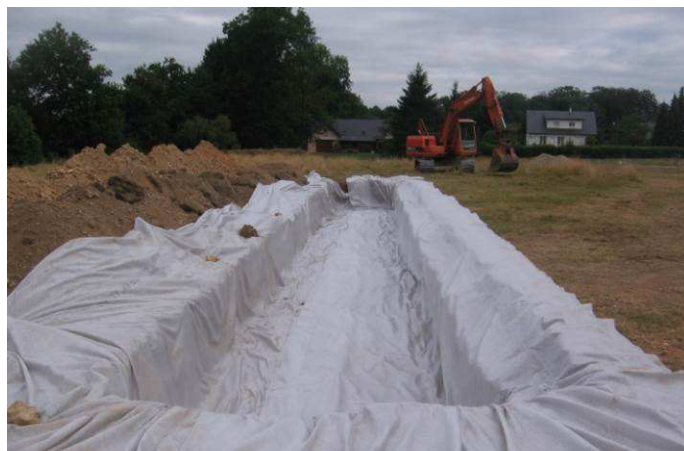
Mise en place du géotextille
