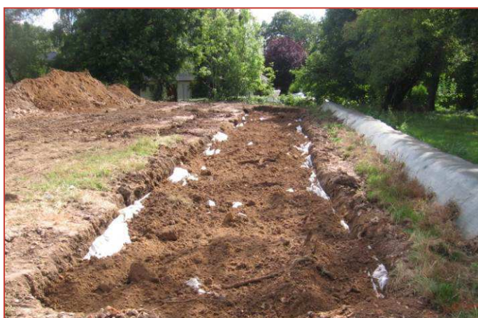
Mise en place du géotextille et de la terre végétale
