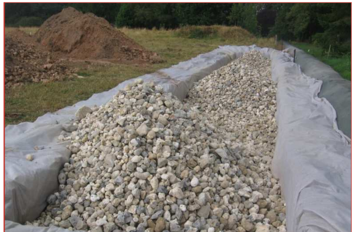
Mise en place du géotextille
