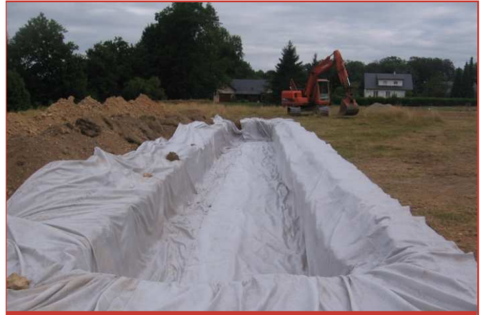
Mise en place du géotextille
