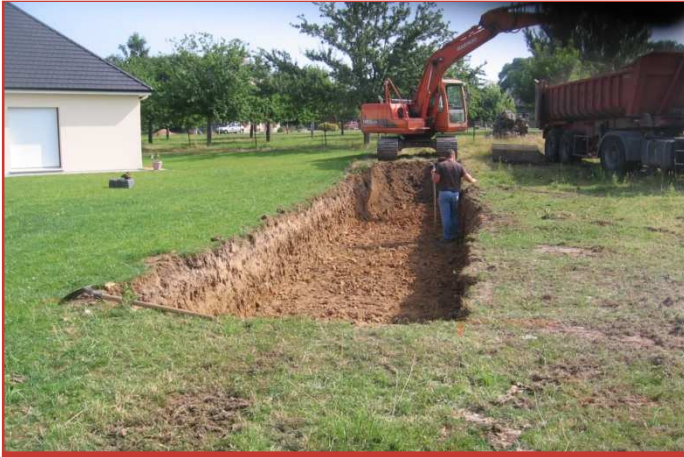
Terrassement du massif drainant
