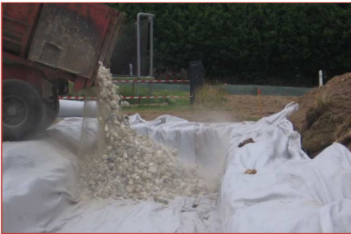
Mise en place de la grève
