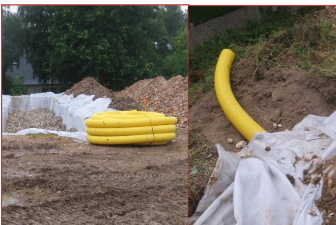
Installation de la canalisation de drainage
