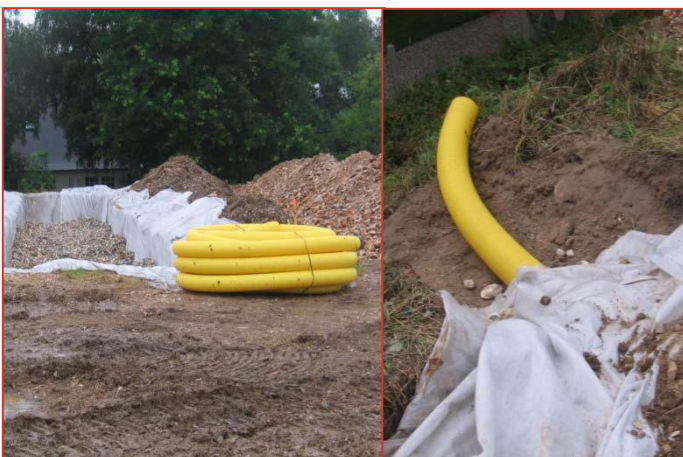
Installation de la canallisation de drainage
