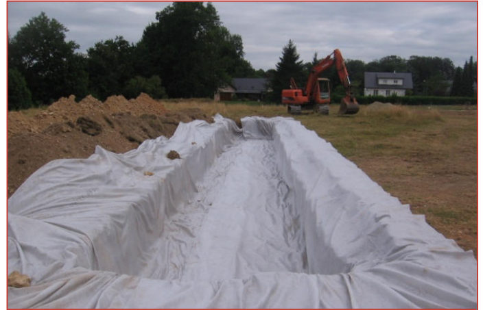
Mise en place du géotextile
