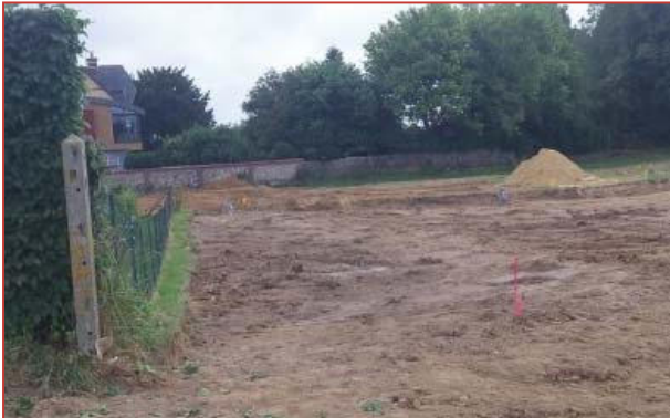
Décapage de la terre végétale
