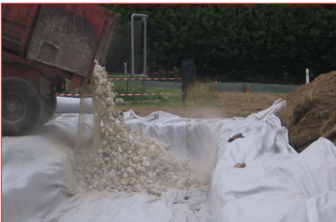
Mise en place de la grave
