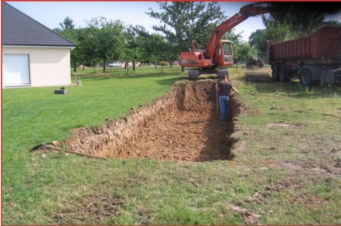
Terrassement du massif drainant
