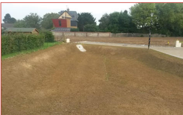
Finition des terrassements
