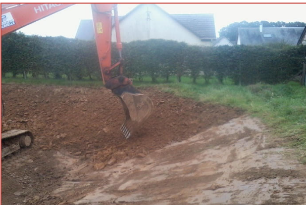
Décompactage et griffage
