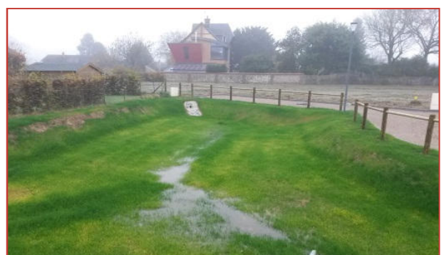
Première mise en eau de l'ouvrage
