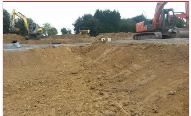
Réalisation des terrassements
