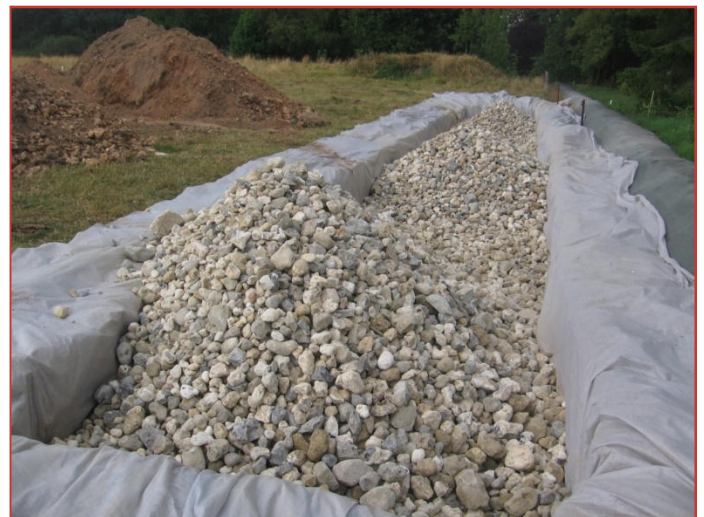
Mise en place du géotextile
