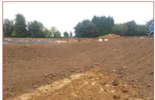
Recapage de la terre végétale
